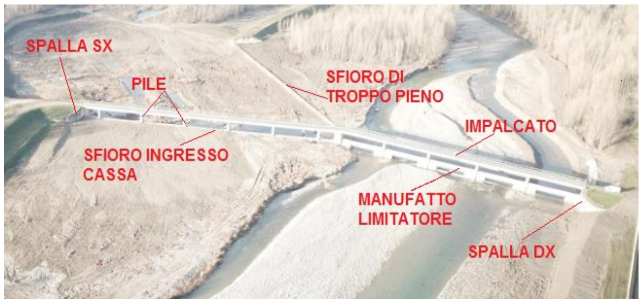
Fig.4.3 - Manufatto limitatore di monte con impalcato
